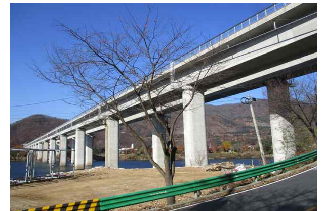
서종대교(양양) 측면 전경
