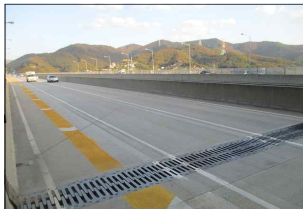
서종대교(서울) 상부 전경
